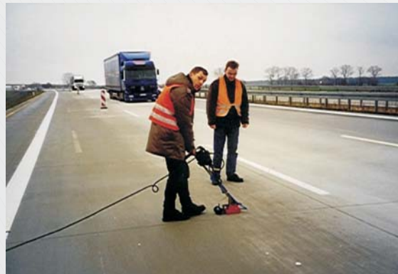
Abb. 2: Durchführung der Radarmessungen entlang einer Querscheinfuge.
