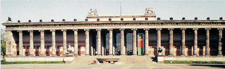
Abb. 1: Eingangsfassade des Alten Museums, Ansicht von der Seite des davorliegenden Lustgartens.
