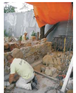
Abb.3: Ansicht auf das Feldsteinmauerwerk
