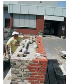
Abb. 1: Ansicht auf den Bereich I mit eingebauten Hohlstellen
