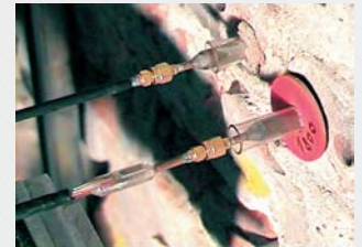
Abb. 5: Antennenpaar im Einsatz an einem Ziegelmauerwerk.
