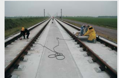
Abbildung 4: IE-Messung im Gleis
