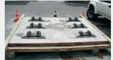
Abbildung 2: Betonierter Probekörper "System Rheda 2000"
