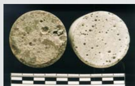
Bild 3/4: Endoskopieaufnahme (Spaltbreite 0,35 mm) und Bohrkern: links: Schwellenoberfläche; rechts: Oberfläche vom Einbettungs beton
