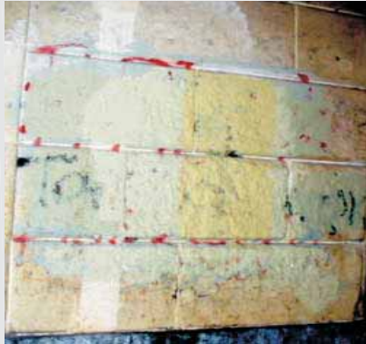
Natursteinmauer nach einer Graffiti-Entfernung ohne Antigrafitti-Schutzsystem
