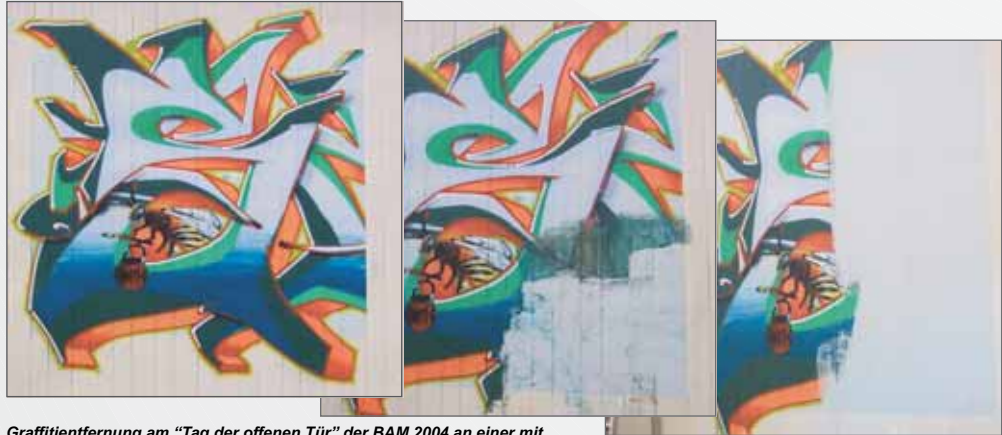
Graffiti-Entfernung am "Tag der offenen Tür" der BAM 2004 an einer mit Antigrafitti geschützten Betonmauer (der geschützte Bereich wurde vorher grau eingefärbt)
