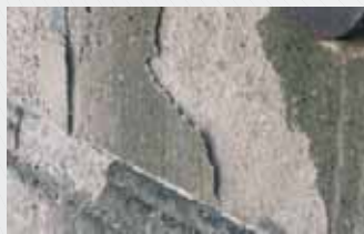
Abb. 2: Rückverwitterung durch Schalenbildung.
