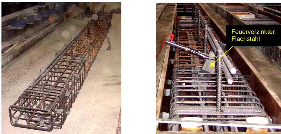
Bild 9: Bewehrungskorb; links: Übersicht; rechts: mit feuerverzinktem Flachstahl; St : Zn = 13 : 1
